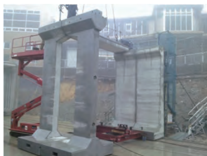
◆敷設状況 2(横引き)
