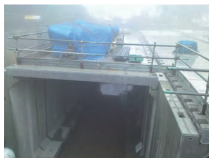
◆頂版スラブ設置状況
