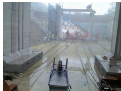
◆敷設状況 1(横引き)
