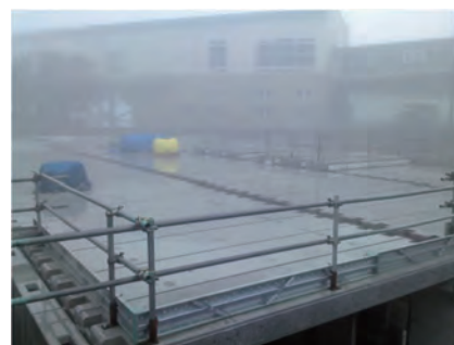
◆頂版スラブ設置完了
