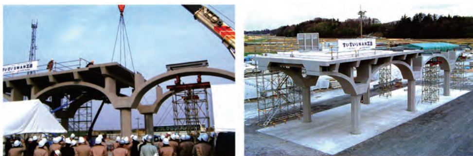
従来の現場打ち高架橋工法の 1/2の工期 で施工できることを確認しました。
