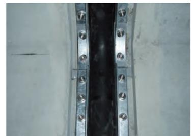
プレキャスト部と現場打ち部を接続する部分で、躯体の伸縮、地震時の変位などを考慮した構造。
