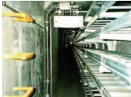
プレキャスト共同溝は、生活に欠かせない「電気・ガス・水道・電話など」のライフラインの構築を助ける製品です。プレキャスト化することにより、現場での急速施工が可能となり、交通渋滞や周辺環境の影響を抑えることが可能です。
