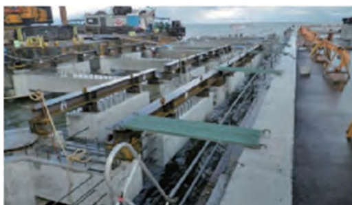
受梁同士の間にも中間梁設置
