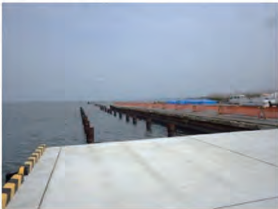
施工前（既設鋼管杭のみ）
