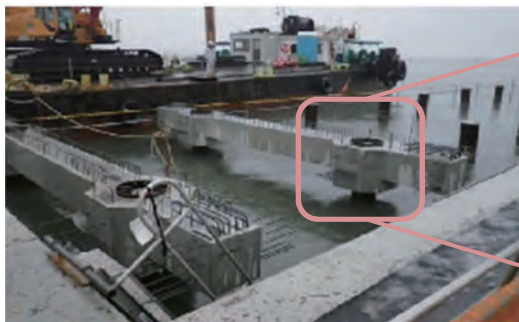
既設杭に受梁設置
