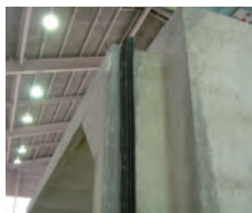
IBゴムリング貼付け
