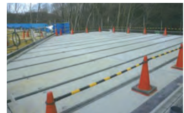
駐車場の床版
