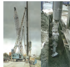
オーガ建込み工法 (SPACE 工法)
