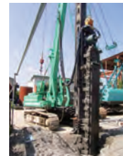
建込み工法 (ミニウォール工法)
