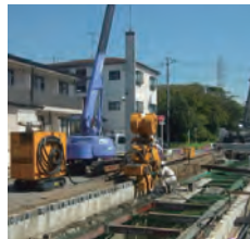
圧入工法 (サイレントパイラー)
