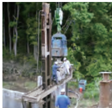
電動式バイプロハンマ + ジェット併用工法
