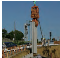
油圧式バイプロハンマ + ジェット併用工法
