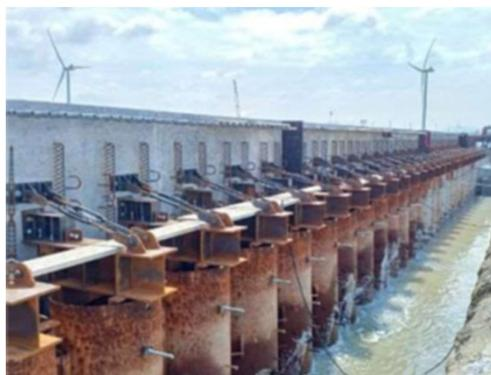
鋼管矢板へのPCa壁設置状況
