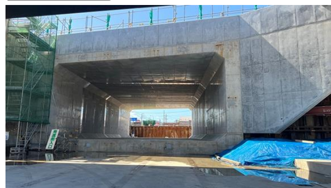
推進完了状況
