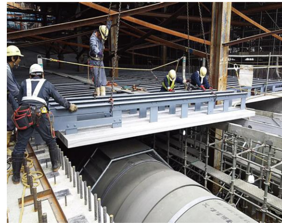
ガッチリフォーム(埋設型枠プレキャストコンクリート頂版) (横河NSエンジニアリング㈱との共同開発)
