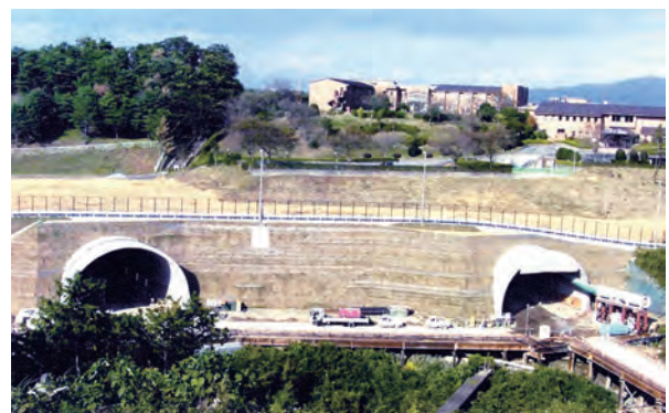
道路トンネル(開削トンネル)
