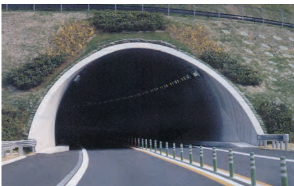
道路トンネル(坑門工)
