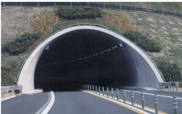
道路トンネル(坑門工)
