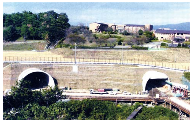
道路トンネル(開削トンネル)
