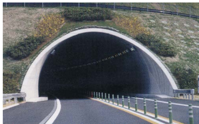
道路トンネル(坑門工)
