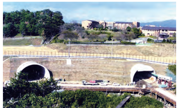
道路トンネル(開削トンネル)
