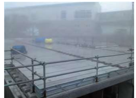
◆頂版スラブ設置完了
