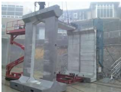
◆敷設状況 2(横引き)
