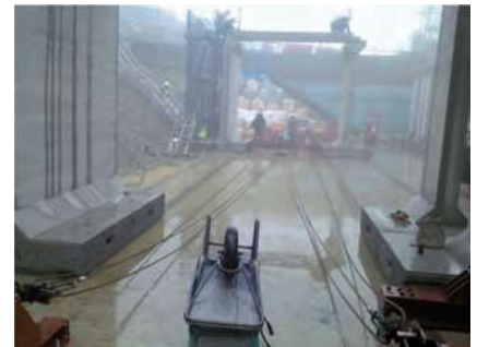
◆敷設状況 1(横引き)
