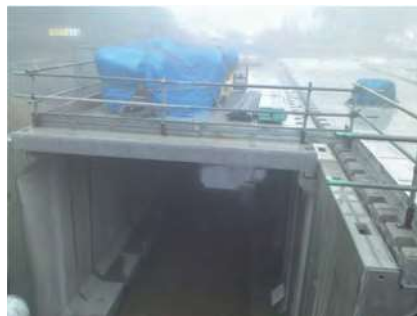
◆頂版スラブ設置状況
