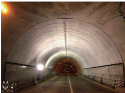
完成写真（坑内より撮影）
