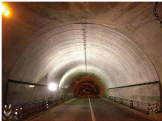
完成写真 (坑内より撮影)
