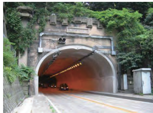
完成写真（坑口より撮影）
