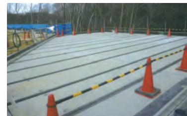
駐車場の床版
