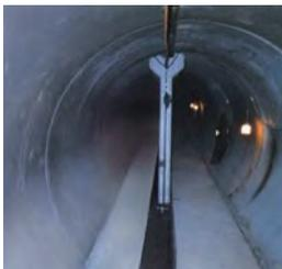
プレキャスト背割板工法は、雨水と汚水を分流したり、鉄道や河川の伏越し部（サイフォン）を管理するため、推進工法等で敷設された管渠を分割する工法です。JIS および各工業会の認定を受けた工場生産されたプレキャストコンクリート背割板を特殊台車等により管路内に運搬・据付けを行い、管路を二分します。
